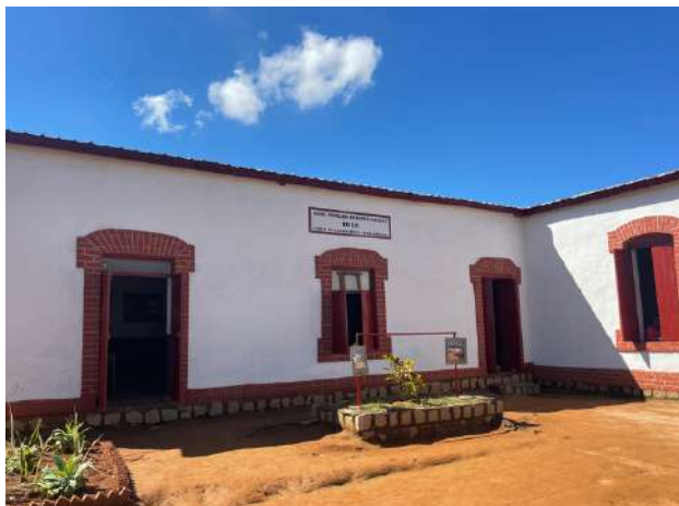
Travaux de réhabilitation des bâtiments
